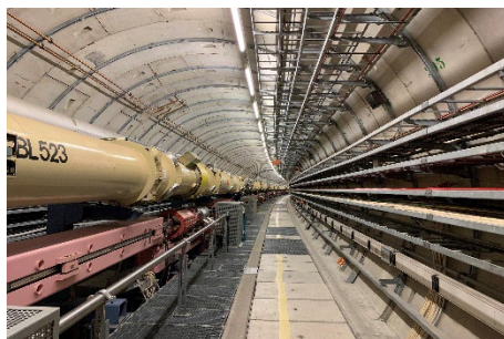
Blick in den HERA-Tunnel Bildquelle: Thomas Malicki
